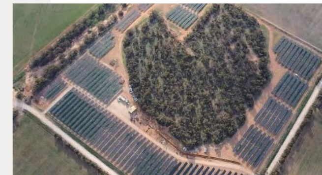
澳大利亚 迈波隆加 4.95MW 地面电站 2022年 双玻405W
